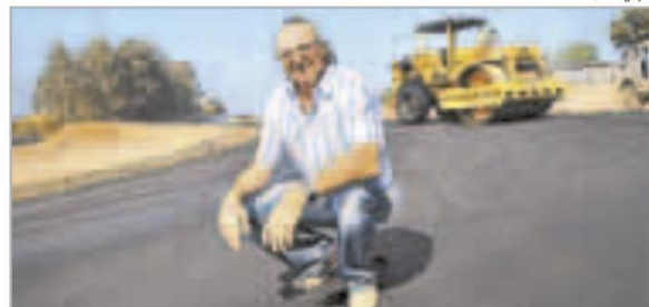
Dito Giannetti por ocasião da pavimentação da pista: visionário
