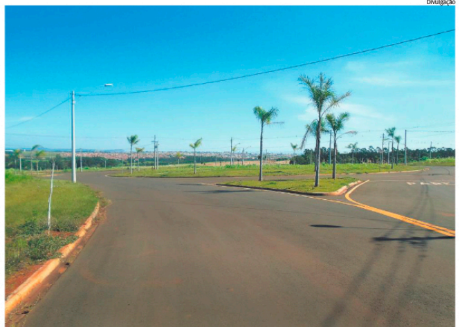
Residencial Campos do Conde Taquaral terá lotes para construção imediata
